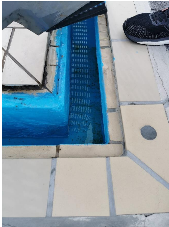
Abbildung 2 – maroder Beckenkopf
