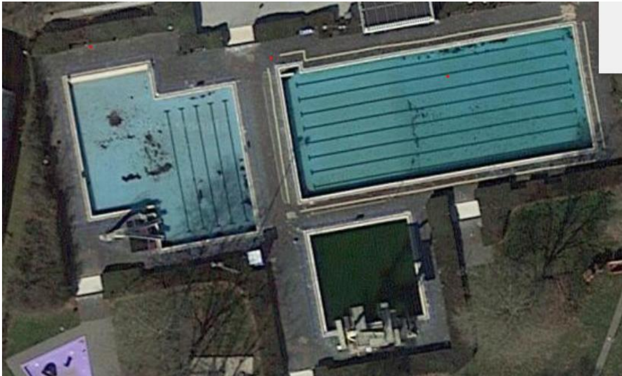
Abbildung 1 – Luftbild des Freibades Egelsbach (Quelle: Google Maps)
